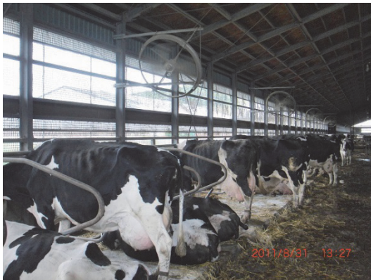
・送風機の設置例
