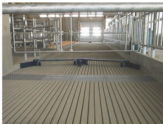
・ 滑りづらい通路床の例
