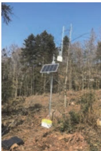
Alptracker アンテナコンプリートパッケージの全範囲は、LoRaWAN アンテナ、耐候性ゲートウェイ、および 12 ボルトのバッテリーで構成される高性能送信機システムで構成されている。内蔵のソーラーパネルにより、システムは自律的で、事実上どこにでも配置できる。15km 以上の通信距離で、広いエリアをカバーすることもできる。
