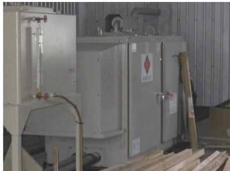
強制換気型鶏舎では、停電等が発生した場合、鶏舎内の換気が十分に行えなくなるため、停電時に手で開口できるインレットや自家発電設備を設置するなどの対策をとることが重要です。
