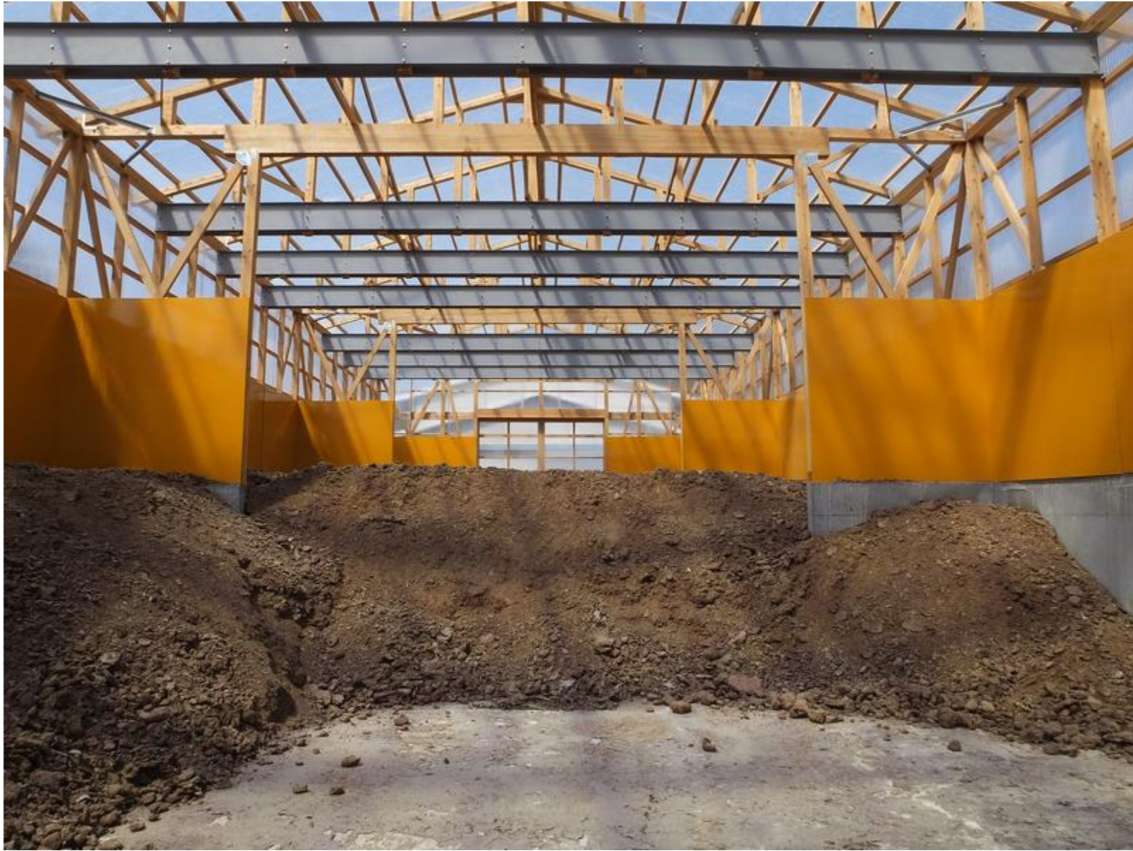
ブロイラー農場の鶏糞倉庫
