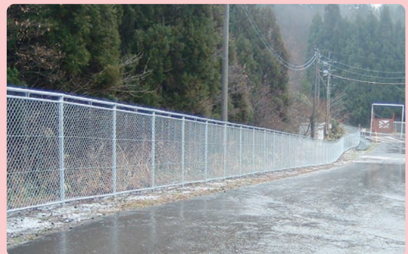
農場の外周にフェンスを設置
