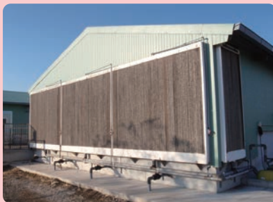
クーリングパッドの設置
